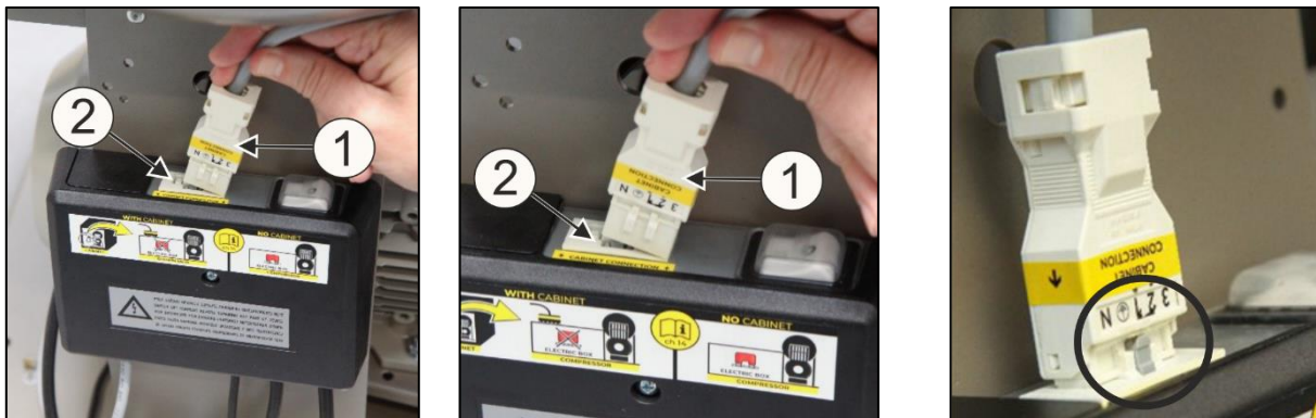
Fig. 11: Raccordement de l'armoire au compresseur
