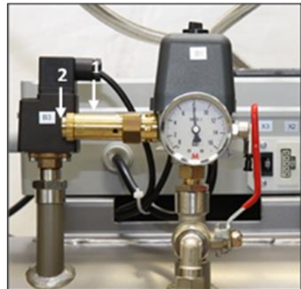
Obr. 25: Kontrola pojistného ventilu
