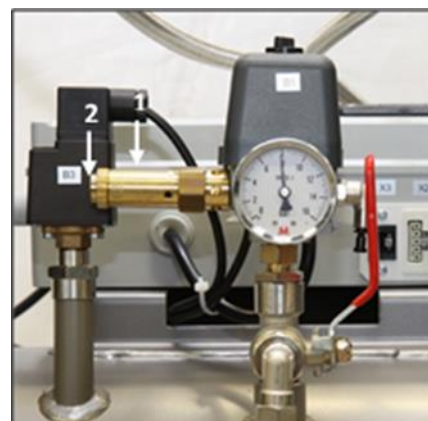
Рис. 25: Проверка предохранительного клапана
