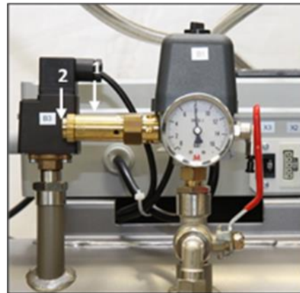
Fig. 25: Contrôle de la soupape de sécurité
