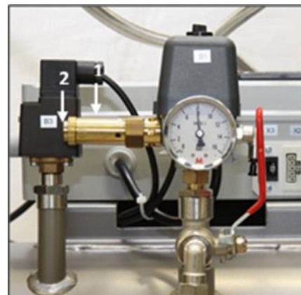
Obr. 25: Kontrola poistného ventilu
