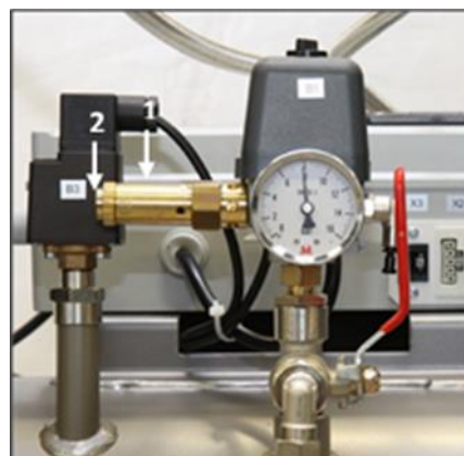
Obr. 25: Kontrola pojistného ventilu
