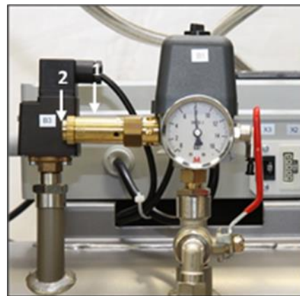
Fig. 25: Contrôle de la soupape de sécurité
