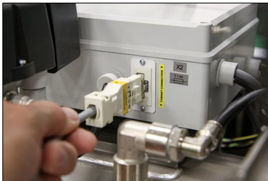
Рис. 13: Подключение шкафа к компрессору
