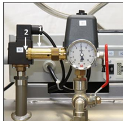
Obr. 25: Kontrola poistného ventilu
