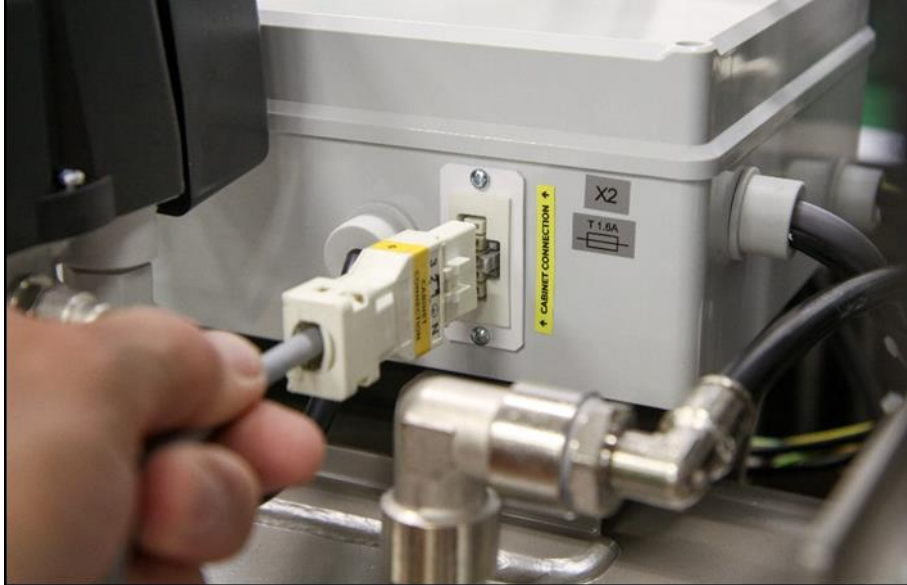
Obr. 13: Zapojenie skrinky ku kompresoru
