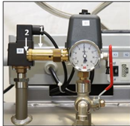
Fig. 17: Contrôle de la soupape de sécurité
