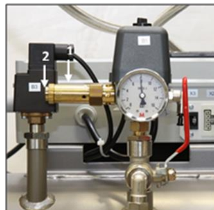
Obr. 17: Kontrola pojistného ventilu
