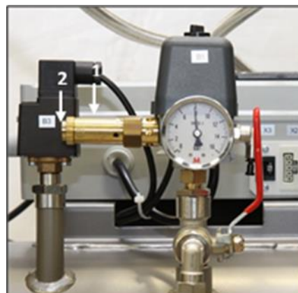
Obr. 17: Kontrola poistného ventilu
