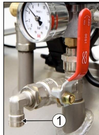
Obr. 8: Pripojenie k výstupu stlačeného vzduchu
