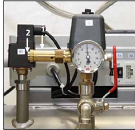
Obr. 25: Kontrola poistného ventilu
