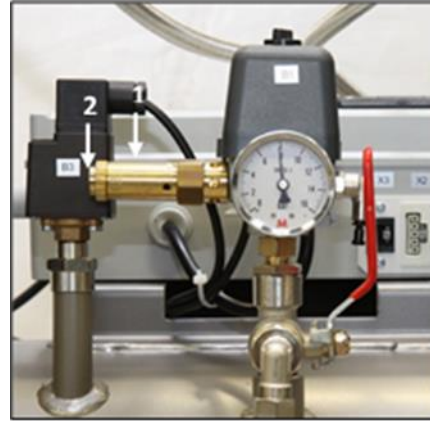
Obr. 17: Kontrola poistného ventilu
