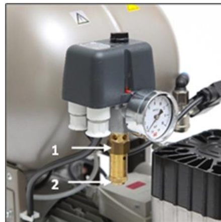
Obr. 7: Kontrola poistného ventilu
